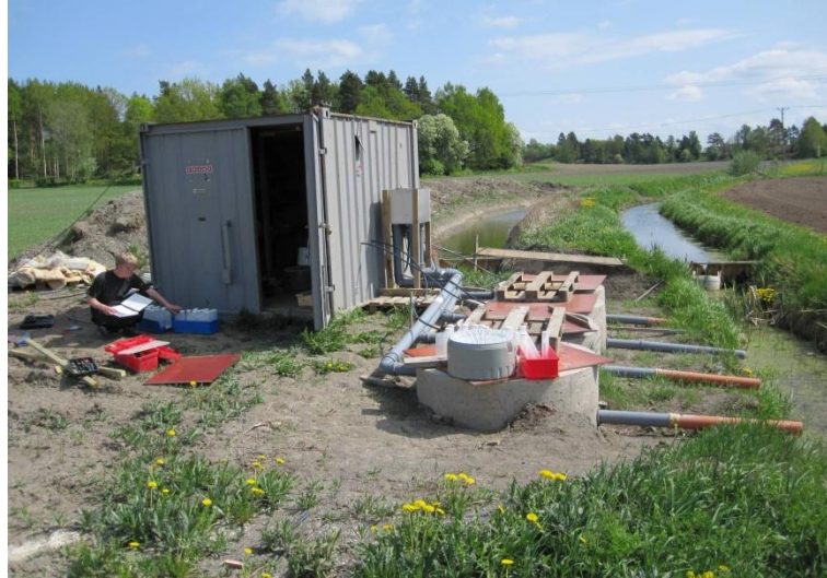
Figur 11: Anläggningen utanför Rimbo. På alla tre anläggningarna ligger filterbrunnarna uppe på dikets sida och vattnet pumpas upp till dem, för att få kontroll på hur mycket vatten som rinner igenom. Vid operativ tillämpning kommer brunnarna att ligga nere i diket, och vattnet kommer att rinna igenom med självfall.
