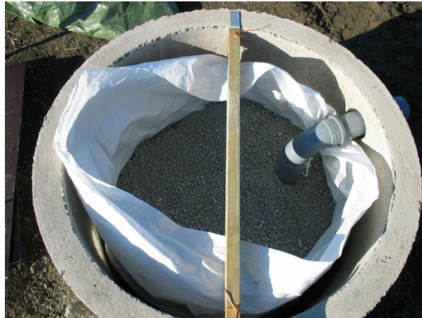
Figur 9: Brunn med filterkassett.
